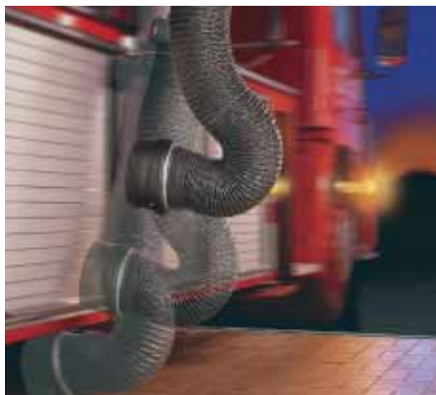
Sistema de gases de extracción de gases de escape para parques de bomberos.
