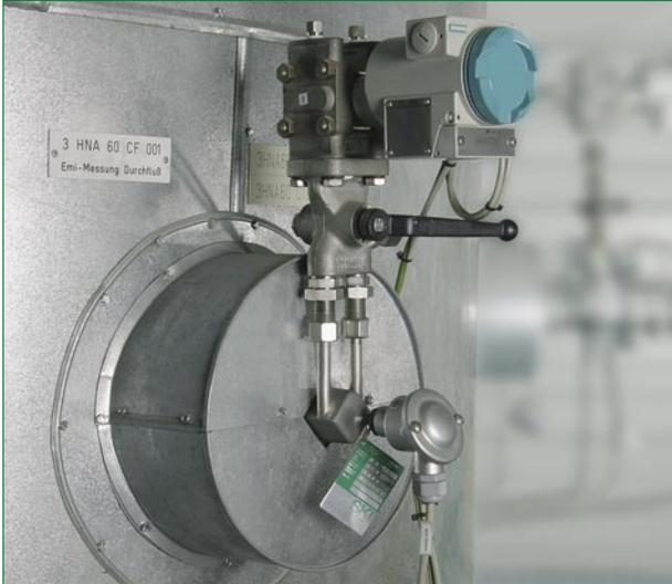
Desde siempre la sonda SDF ha sido unida a la medición de gases sucios debido a agua o polvo.
