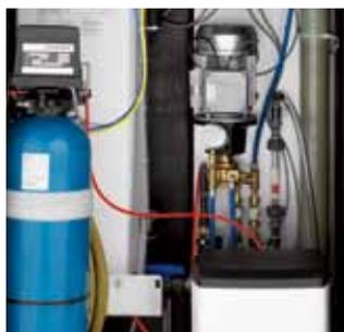
Limpeza delicada con la instalación: las instalaciones de descalcificación previenen la formación de depósitos de cal, asegurando así la durabilidad de los componentes técnicos.
