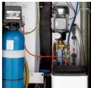
Brillo sin pulido posterior: las instalaciones de descalcificación previenen la formación de depósitos de cal, asegurando así la durabilidad de los componentes técnicos.
